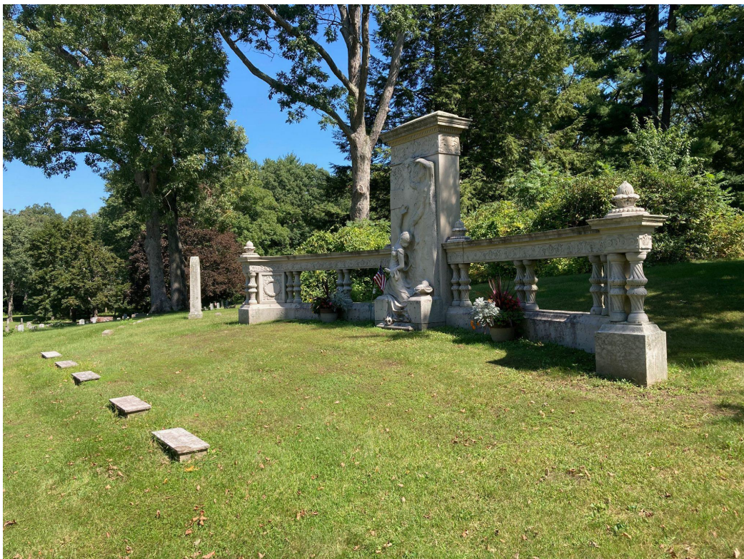
Fyler monument (Job #06959).
